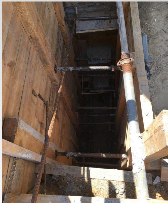
Dreistufige Fundamentunterfangung
